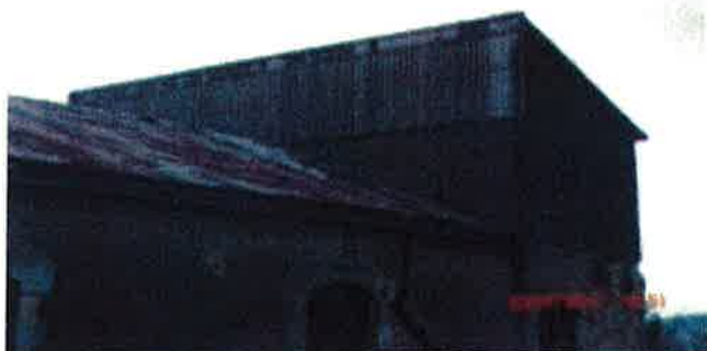
Composant : Plaques ondulées et panneaux en façade fibro-ciment Partie surélevée 1 pente
