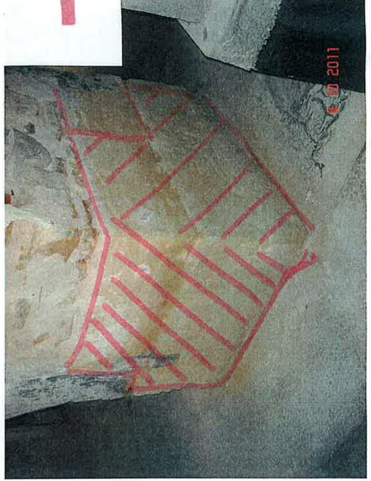
SALLE VOUTEE ACCESSIBLE PIOCHEMENT POUR MISE A NU DES VOUTES ET DES PAREMENTS REPRISE EN PIERRE DE TUFFEAU DEMOLITION CLOISON EN BRIQUE CLOISONS EN PARPAINGS NON TOUCHEES
