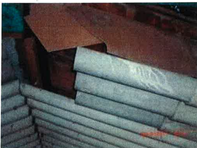
face en plaques de fibrociment)
