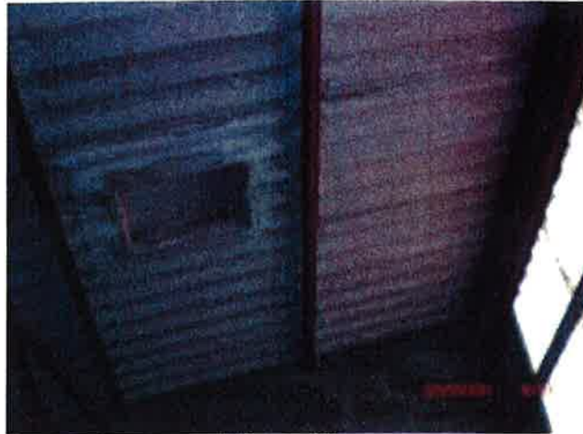
Composant : Plaques ondulées en toiture Couverture 1 pente apparente en sous face de la mezzanine
