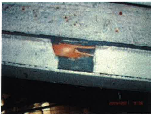
habillage en plaques de fibrociment)
