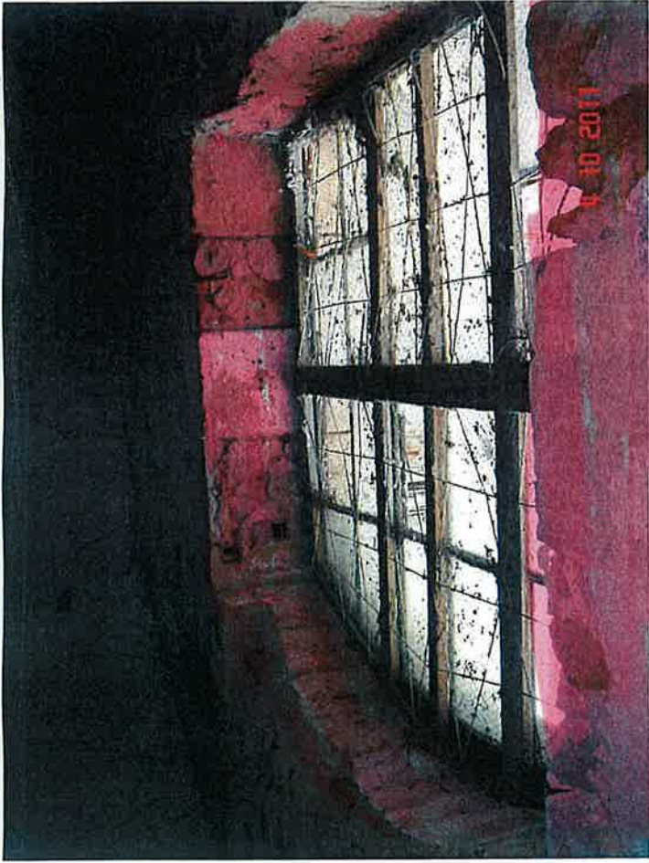
SALLE VOUTEE ACCESSIBLE PIOCHEMENT POUR MISE A NU DES VOUTES ET DES PAREMENTS REPRISE EN PIERRE DE TUFFEAU DEMOLITION CLOISON EN BRIQUE CLOISONS EN PARPAINGS NON TOUCHEES
