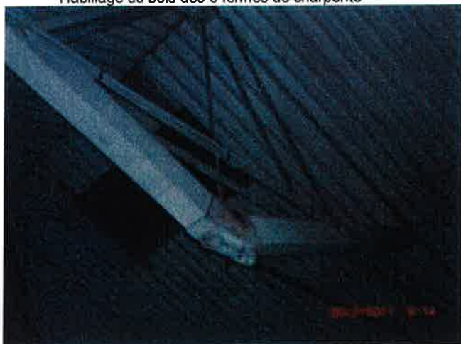
Composant : Entourages de poteaux plaques fibro-ciment Habillage du bois des 5 fermes de charpente
